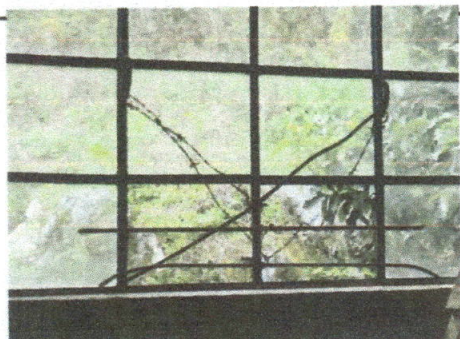
Foto 5: Instalacion de vidrios transparentes.
