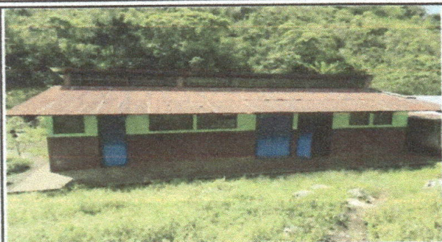
Foto1: Sustitucion de cubierto de lamina de 16.00 mts x 12.00 mts
