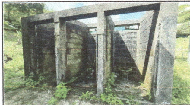
Foto 4: remodelacion, ampliacion y Colocacion de puertas de metal del sanitario.
